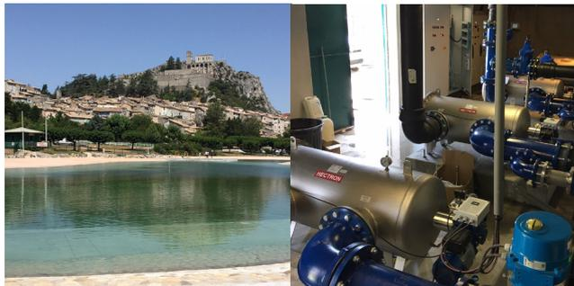
Filtration d'un plan d'eau de baignade. Filtration de l'adduction d'eau (forage) (AG400 1-3 µm) et de l'eau du plan d'eau en circuit fermé : 3 filtres AG400 316L en 50 µm.
