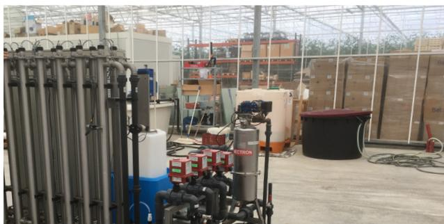
Filtration d'eau en boucle fermée, pour l'irrigation de tomates en serre. Filtration 20 µm avant système UV.
