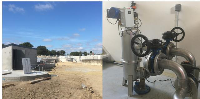
Filtration en sortie de clarificateur, avant lagunage. Filtre AG200 2" en 400 µm.
